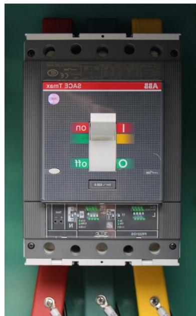
图（7）电源总开关
