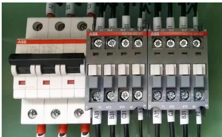
图（6）小电流回路开关
